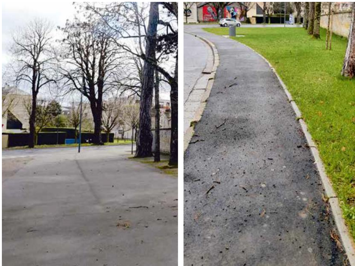
Slika 103 Uklanjanje dijela asfalta u ulici Eugènea Boudina (Izvor: Ville de Caen)
